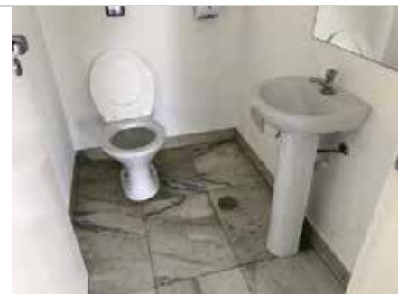
Visão Geral – Banheiro Andar Tipo
