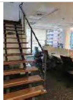
Escada para mezanino (8º Andar)
