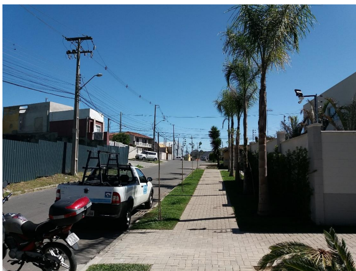
Rua Casemiro Augusto Rodacki, com o imóvel à direita
