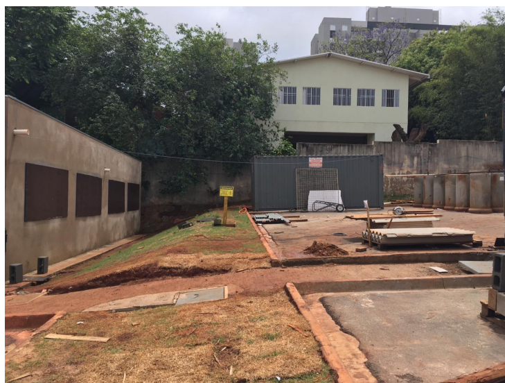
Vista geral do imóvel
