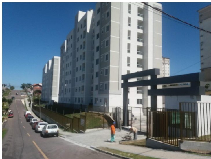
Frente do imóvel para Rua Capitão João Zaleski
