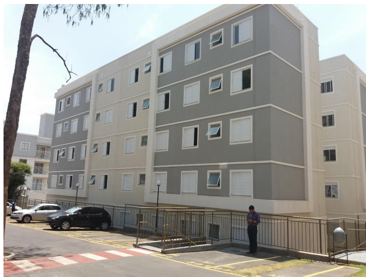
Vista geral do imóvel
