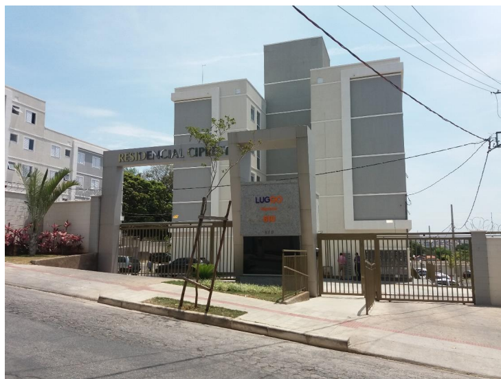
Frente do terreno para Rua das Espatódias
