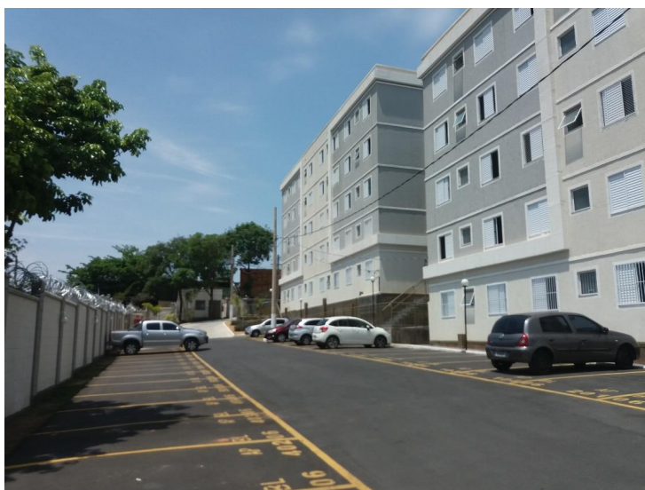
Pátio de estacionamento
