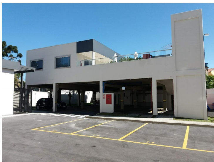
Vista do acesso para o estacionamento coberto
