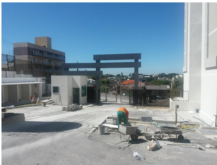
Vista do acesso externo do imóvel
