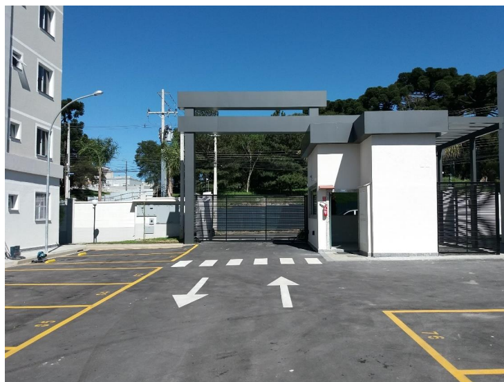
Vista do acesso externo do imóvel
