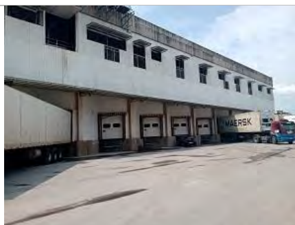
Fachada Galpões C6 e C7
