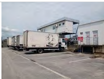
Área de apoio ao motorista
