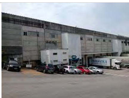
Fachada Frontal Galpão C
