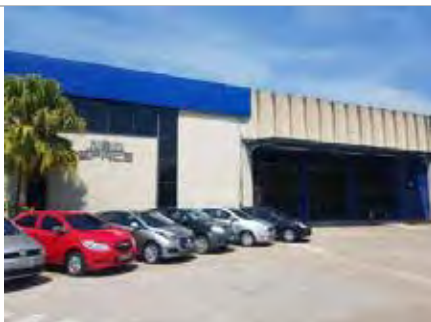
Acesso ao Galpão
