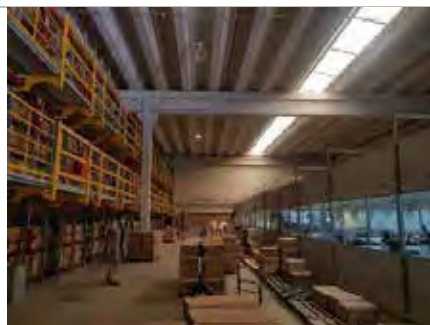
Vista Geral Controle / Armazenamento
