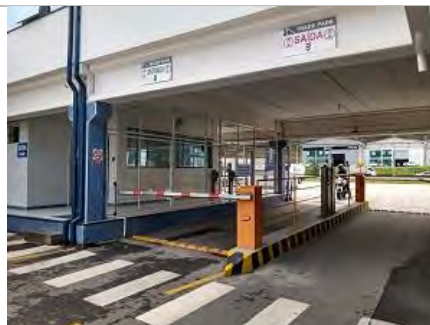
Guarita de controle de acesso
