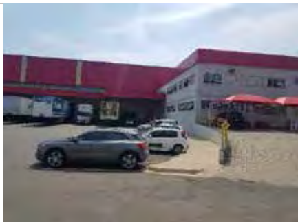
Vista externa do Bloco II
