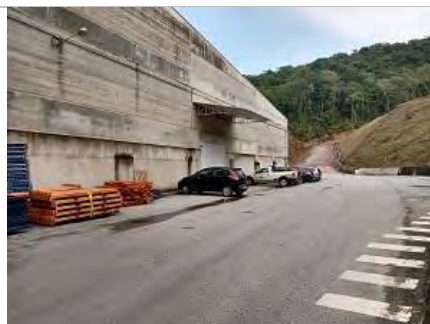
Fachada Lateral Galpão C
